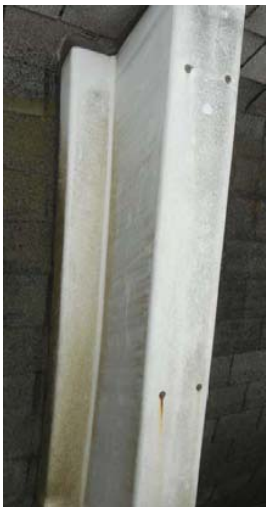
Cobertura de resina y fibra que protege las ménsulas
