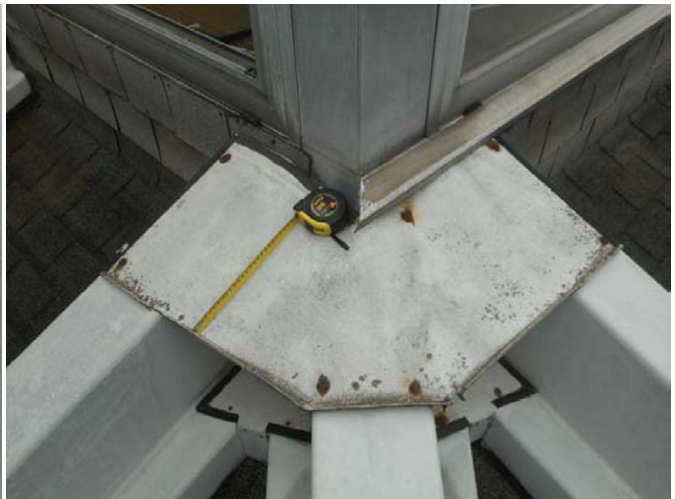
Tornillería oxidada en encuentro entre ménsulas y lucernario
