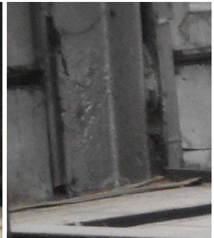
Pie de pilar saneado con pérdida de material por herrumbre
