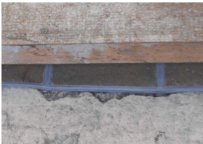
Encuentro con cornisa: Placas deformadas, teselas partidas; y apoyo irregular y directo de los plafones sobre el mortero en el perímetro
