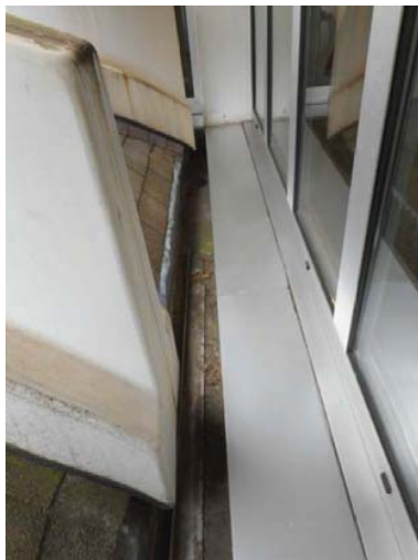
Cobertura de resina y fibra que protege las ménsulas
