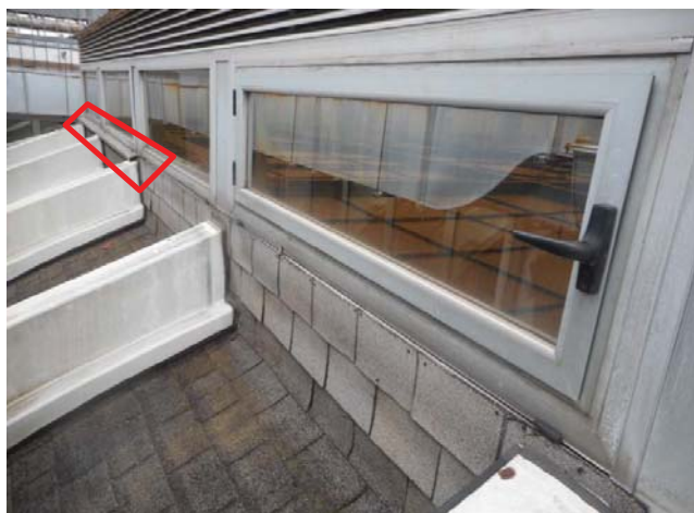
En rojo, pletina que remata la impermeabilización
