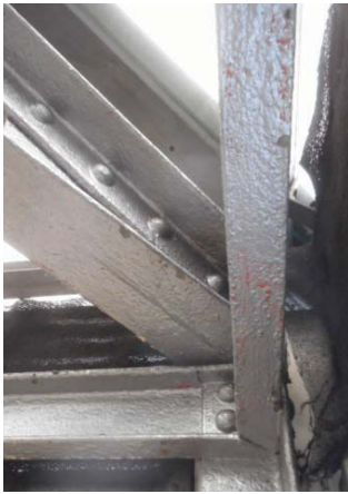
Falta de pintura de protección
