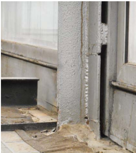
Pie de pilar con injertos y pequeñas oxidaciones
