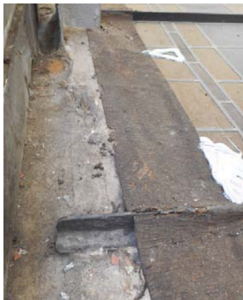
Fijaciones de teselas rotas con silicona, vista de la cara superior, y tela adherida
