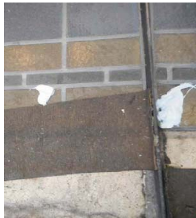
Fijaciones de teselas rotas con silicona, vista de la cara superior, y tela adherida
