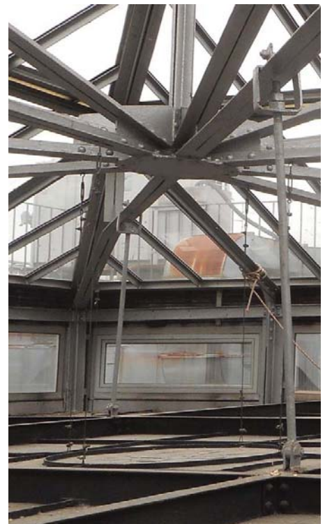
Montantes y tensores suspendidos de la estructura del lucernario
