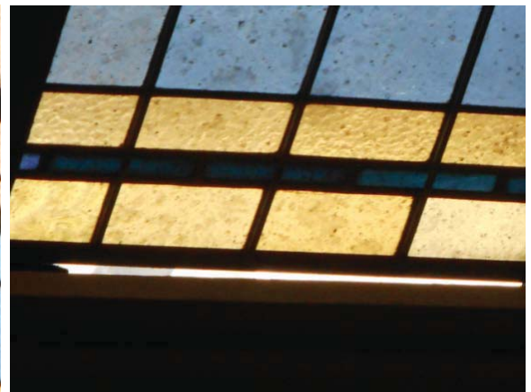
Hueco existente entre vidriera y cornisa
