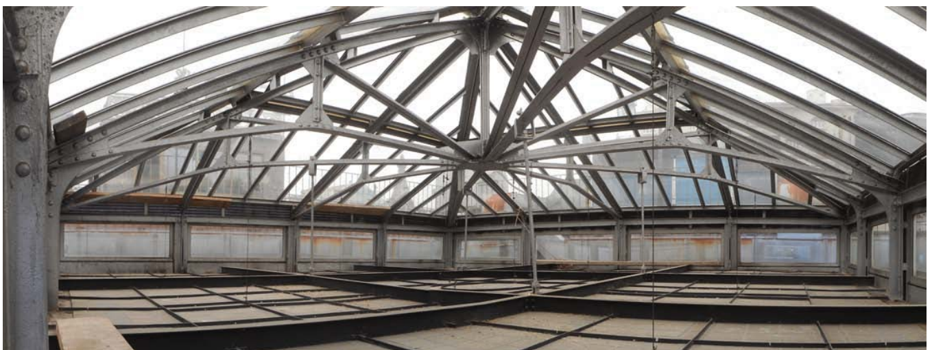
Imagen panorámica actual del interior del lucernario, arriba la cobertura de vidrio, y abajo el envés de la vidriera
