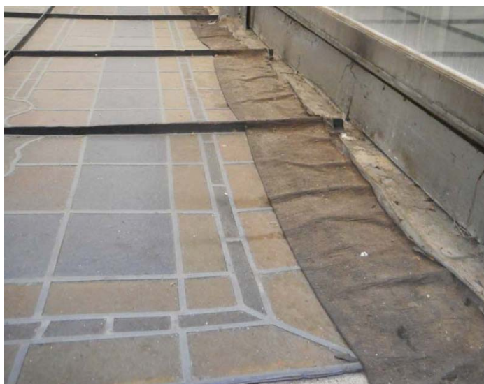
Tela adherida en encuentro con cornisa, vista superior. Vista inferior, con sombras proyectadas por la tela
