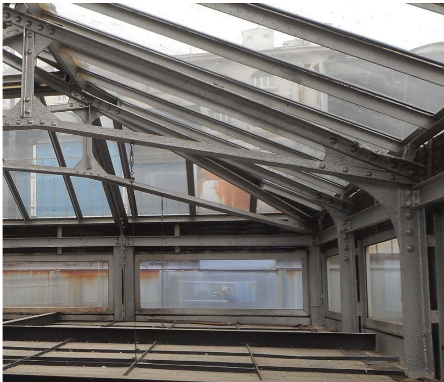
Detalles estructura roblonada
