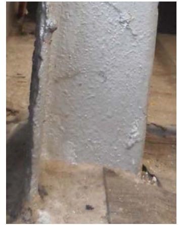
Pie de pilar saneado, con pérdida de material por herrumbre
