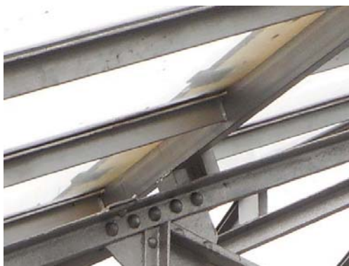
Vista inferior del decalaje entre vidrios para ventilación
