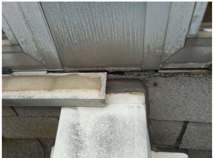
Materiales degradados en juntas y uniones
