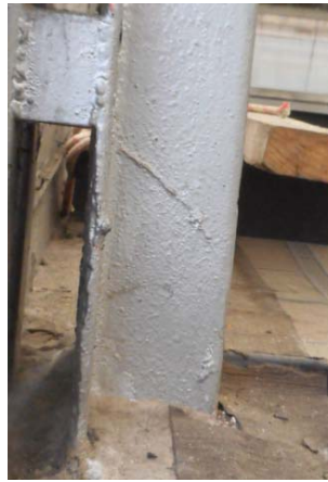
Pie de pilar saneado, con pérdida de material por herrumbre
